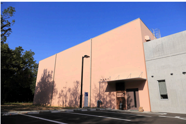
写真1: 牧野標本館・別館の植物標本庫棟(薄ピンク色の建物)
